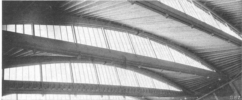
Abb. 2. Untersicht des Daches der Haupthalle VIII (1941/42). Stützweite 45,46 m
