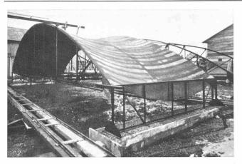
Abb. 14. Schalen-Binder (in Montage)
