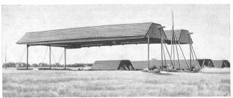
Abb. 15. Freitragendes Wellblechdach (in Montage)
