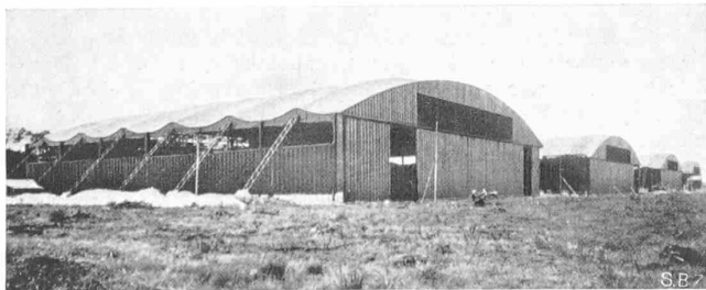
Abb. 13. Flugzeughalle mit Schalenbindern
