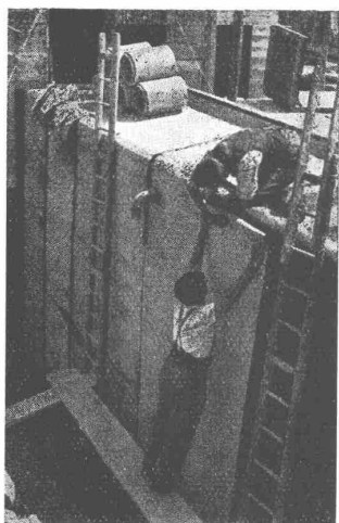
Wand-Isolierung gegen Grundwasser
