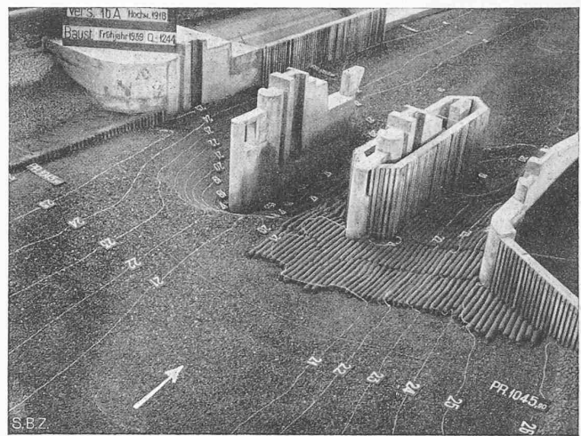
Abb. 6. Mit teilweiser Sohlenabdeckung
