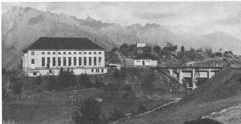
Abb. 4. Zentrale Oberems, rechts die Mauer des Ausgleichbeckens
