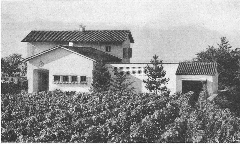
Fig. 2. Vue d'ensemble du coin nord-ouest du terrain
