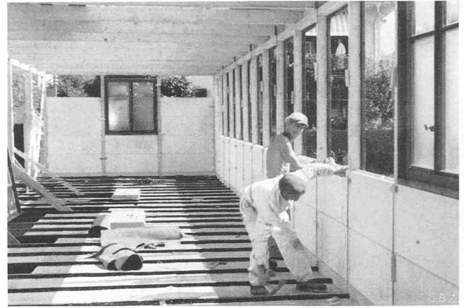
Abb. 10. Durisol-Blindboden. Einsetzen der Platten und Fenster
