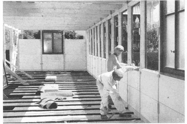
Abb. 10. Durisol-Blindboden. Einsetzen der Platten und Fenster
