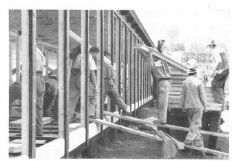
Abb. 9. In das aufgerichtete Skelett werden Durisolplatten eingebracht, für die die äusseren Deckleisten schon in der Werkstatt mit den Pfosten der Konstruktion verschraubt worden sind
