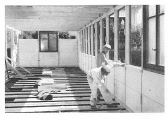
Abb. 10. Durisol-Blindboden. Einsetzen der Platten und Fenster
