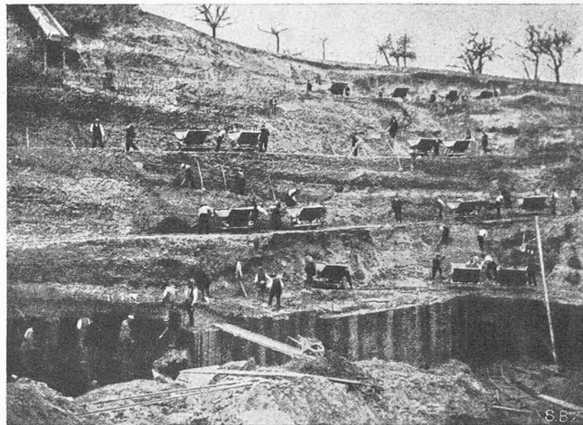
Abb. 4. Schieferkohlengrube Zell-Gondiswil, Kanton Luzern Abbau während des letzten Krieges
