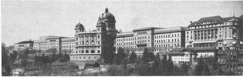
Abb. 2. Vorschlag Arch. A. R. STRÄSSLE (Zürich) für Aufstockung des West- und Ostbaues Mittelbau und Hotel Bellevue (rechts) unverändert, Bernerhof Obergeschoss (links aussen) vereinfacht. Bundeshaus West und Ost aufgestockt, unter Belassung des Kranzgesimses. Bundeshaus West und Ost aufgestockt, unter Belassung des Kranzgesimses. Bundeshaus West mit Bernerhof durch eine Galerie verbunden, die die kubische Erscheinung der Baukörper nicht weiter stört; an der Bundesgasse neuer Verbindungstrakt (Abb. 3), in Abb. 2 über dem Dach von Bundeshaus West sichtbar. Die Gesamtsilhouette würde zweifellos geschlossener und ruhiger wirken. Red.
