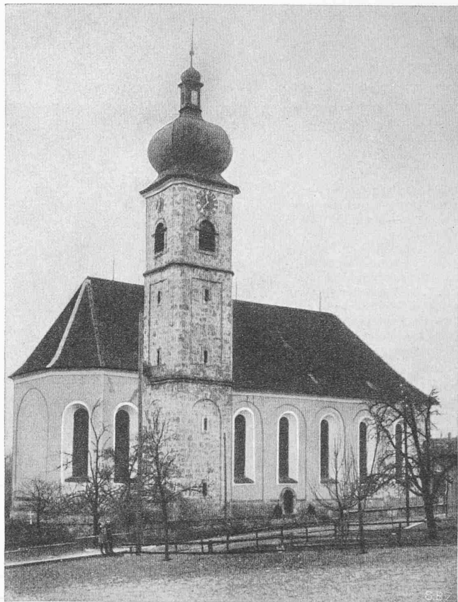
Katholische Pfarrkirche Niederhelfenschwil (Kt. St. Gallen) Turm im schönsten Tuffstein-Mauerwerk. Wie bei vielen Dorfkirchen des Barock lässt das betont schlichte Aeusserer den Reichtum des Innern nicht ahnen — die Ueberraschung wirkt umso stärker.
