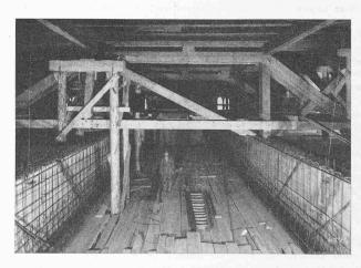
Abb. 4. Einbau der 2,30 m hohen Eisenbetonträger (vgl. Abb. 3) Abb. 4 und 5 Clichés «Hoch- und Tiefbau»
