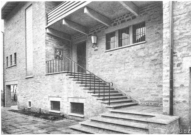
Abb. 8. Freitrepppe zum Hauseingang
