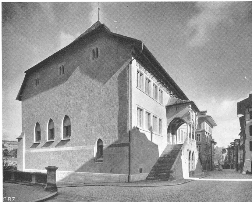
Abb. 9. Westfront, ehemalige Brandmauer gegen die alte Münz
