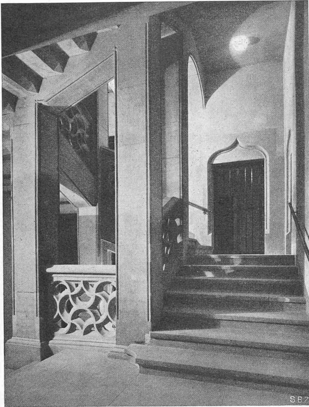
Abb. 18. Treppenhaus im Verbindungsbau (17. Jahrhundert)
