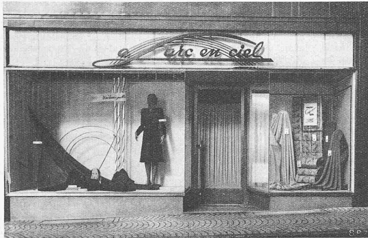
Fig. 2. La nouvelle vitrine de la rue de Bourg
