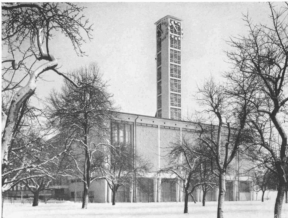
Abb. 11. Ansicht aus Südwest, im Untergeschoss die Fenster des Gemeindesaales
