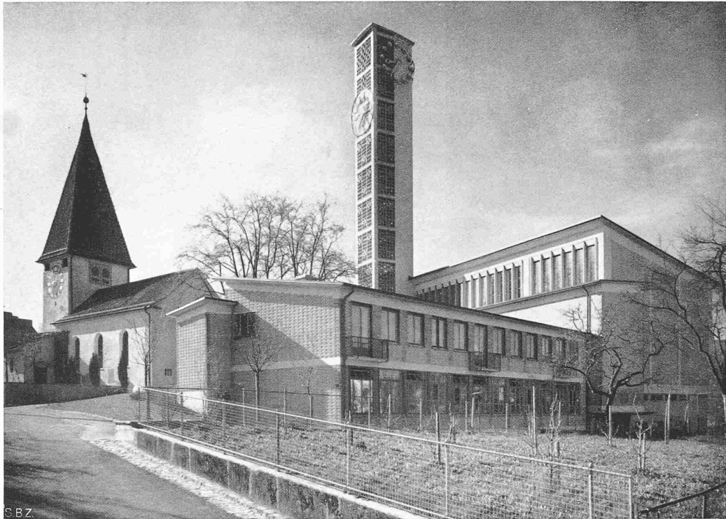
Abb. 10. Gesamtbild aus Norden von alter und neuer Kirche Altstetten
