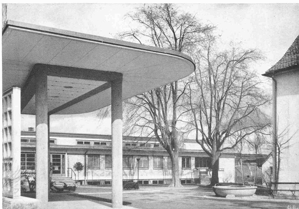
Abb. 5. Blick von der Kirchenvorhalle gegen den Unterrichtsflügel
