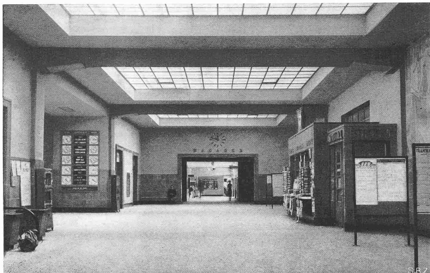
Fig. 6. Le Grand Hall. Fond en asphalte avec bordures granit et panneaux Klinker, soubassement céramique brune, encadrements des baies en céramique rouge vitrifiée, murs et plafond enduits tintés en beige clair
