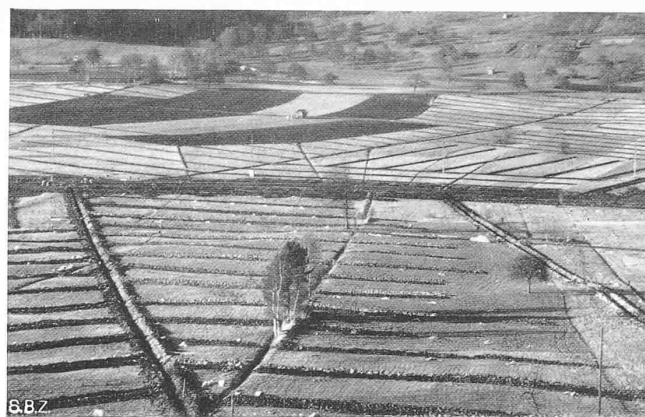
Abb. 8. Drainage «Ittenmoos» im Bau, Winter 1941/42
