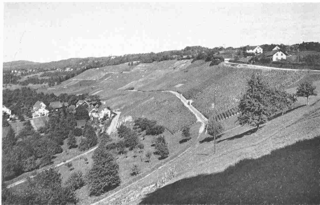
Abb. 3. Heutiger Zustand des «Lattenberges» Stäfa, zusammengelegt und rekonstruiert in den Jahren 1935 bis 1937
