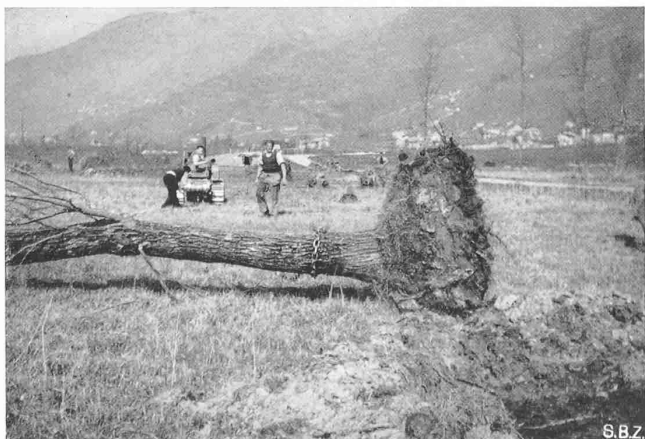
Abb. 1. Umlegung von Bäumen durch Traktorzug
