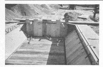
Abb. 4. Brückenschalung einer komb. Waggon- und Fuhrwerkwaage Abb. 5. Brückenarmierung in der Schalung lt. Abb. 4. Legende: D Bremsanschlag, E Auflagerplatten, G Montagestützen für die Schienen
