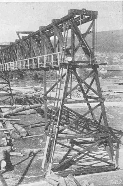
Abb. 3. Portalantrieb an der Stirnseite
