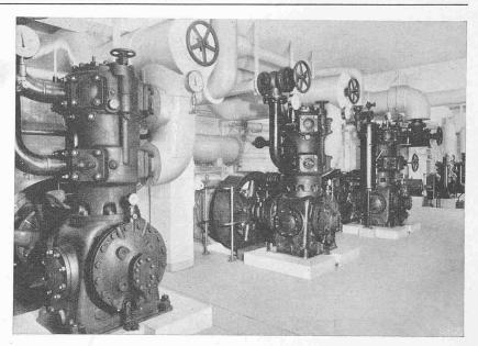
Abb. 7. Maschinenraum mit drei Sulzer-Ammoniak-Kompressoren von je 385 000 Cal/h, im Hintergrund zwei Kompressoren von 34 000 Cal/h bei —  $10\,^\circ$  Verdampfungsund +  $25\,^\circ$  Verflüssigungstemperatur. — Tiefkühlanlage der Konservenfabrik Rorschach
