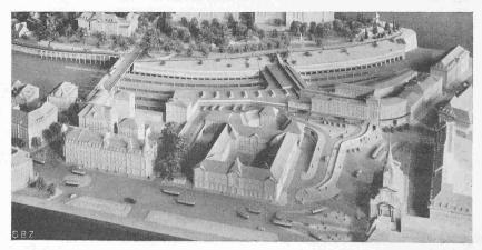
Abb. 4. SBB-Variante II, hintere vier Geleise überwölbt. Offene Auffahrtsrampe
