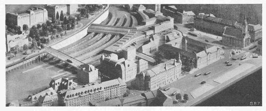
Abb. 2. SBB-Variante I (offene Anlage) zum Umbau des Personenbahnhofs Bern zu einem Reiterbahnhof
