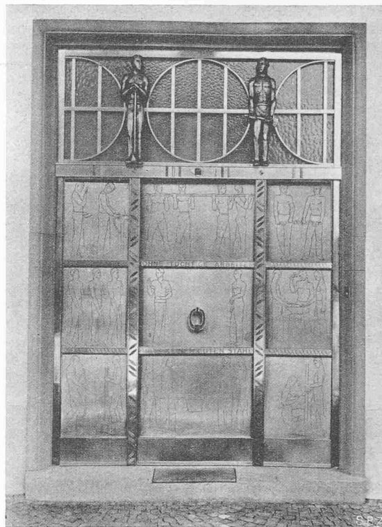
Türe aus nichtrostendem Stahl mit farbiger Email-Schmelzarbeit
