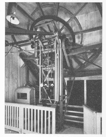
Abb. 4. Führerstand in der Antriebstation (Nachtaufnahme)
