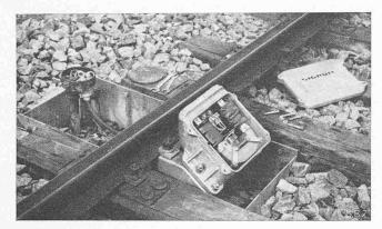
Abb. 12. Impulsgeber «Signum» mit Kabelanschluss, offen
