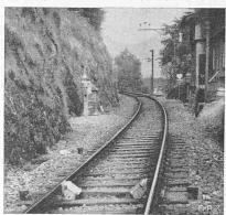
Abb. 11. Impulsgeberpaar; weiter hinten Anschluss des isolierten Schienenstückes
