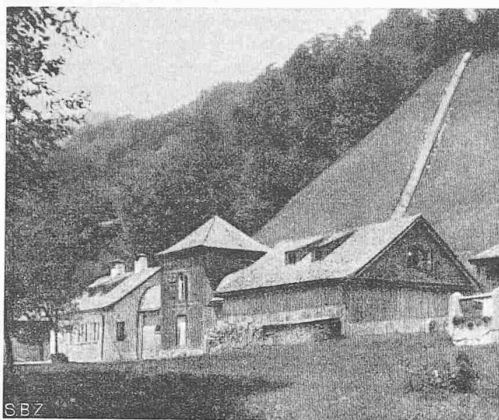
Abb. 4. Brunnhaus in Iilsank bei Berchtesgaden mit Druckleitung auf 356 m Höhenunterschied
