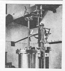
Abb. 5. Wassersäulenmaschine im Brunnhaus Unternesselgraben
