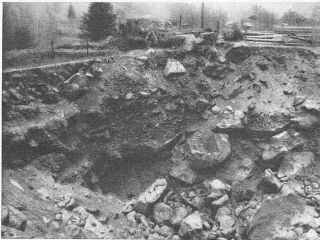
Abb. 1. Tagbruch-Trichter über dem Umlauf-Tunnel
