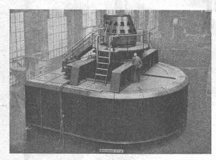
Montage des ersten Grossgenerators v. 27 500 kVA, 18 000 V, 136 U/min, für das Rhône-Kraftwerk Verbois
