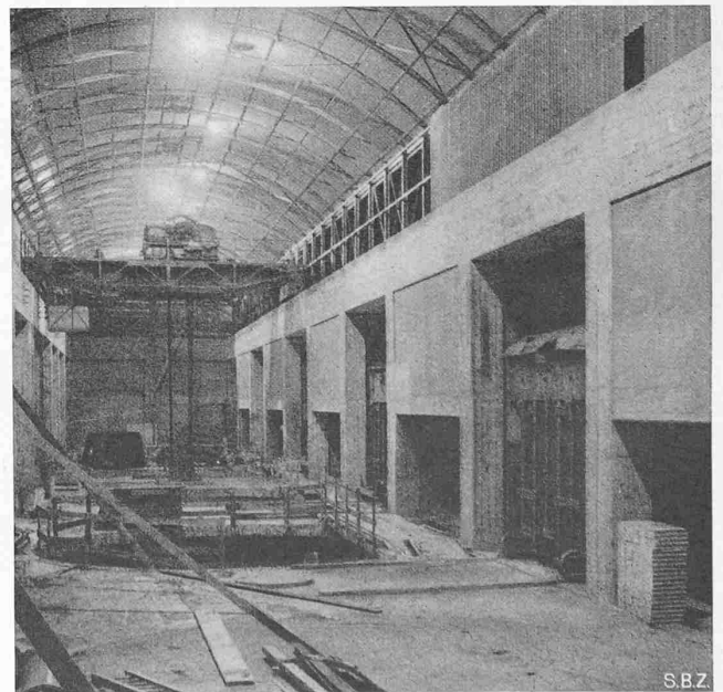
Abb. 37. Dachkonstruktion u. Transformatoren-Nischen, 120 t-Kran
