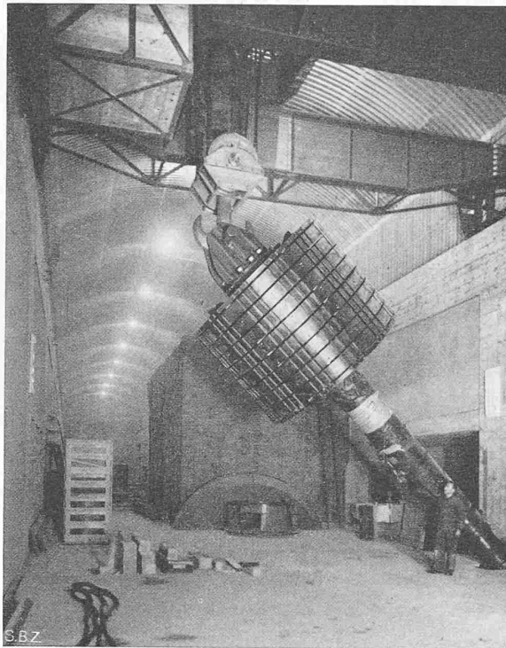
Abb. 48. Rotor-Montage (Photos Brügger A. G., Meiringen)
