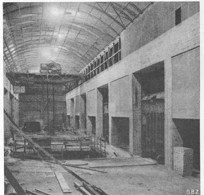
Abb. 37. Dachkonstruktion u. Transformatoren-Nischen, 120 t-Kran
