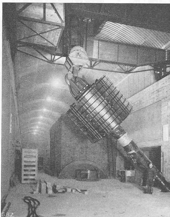
Abb. 48. Rotor-Montage (Photos Brügger A. G., Meiringen)
