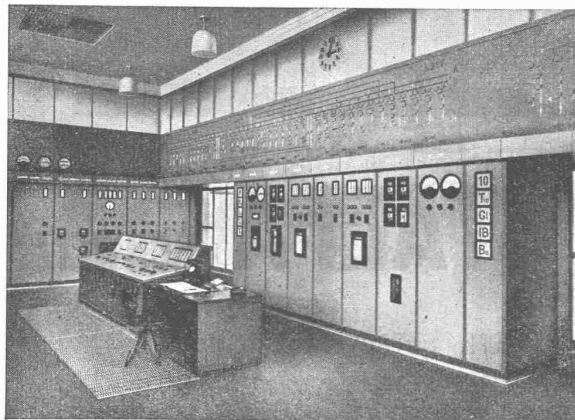
Kommandosaal im Kraftwerk des E. W. der Stadt Schaffhausen Leuchtschema
