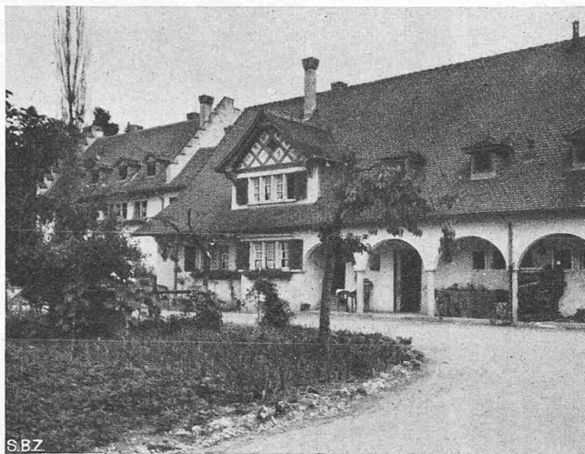
Abb. 11. Haus Typ A, links davon der Verwaltungsbau
