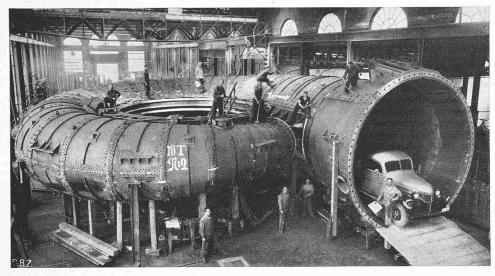
Abb. 1. Spiralfrancisturbine von Escher Wyss, Zürich (H 69 m, Q 144 m²/sec, N 115500 PS, n 125 U/min) für das Kraftwerk Sungari der Manshukoku Denki Suiryoku Kensetsu Kyoku
