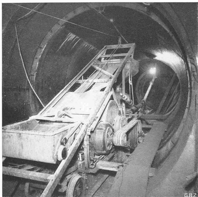
Abb. 13. Betonpumpe, links der Betonaufzugskübel, der in den Einfülltrichter der Pumpe (Hintergrund) kippt. Unter dem Aufzugeleise der 30 PS-Antriebmotor der Pumpe, die bis 7 m 3 /h in die abgehende Leitung fördert
