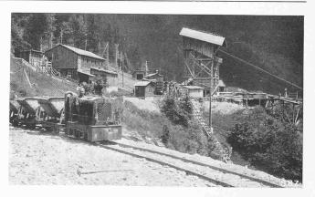
Abb. 6. Obere Endstation der Seilbahn für das Baufenster Hostett
