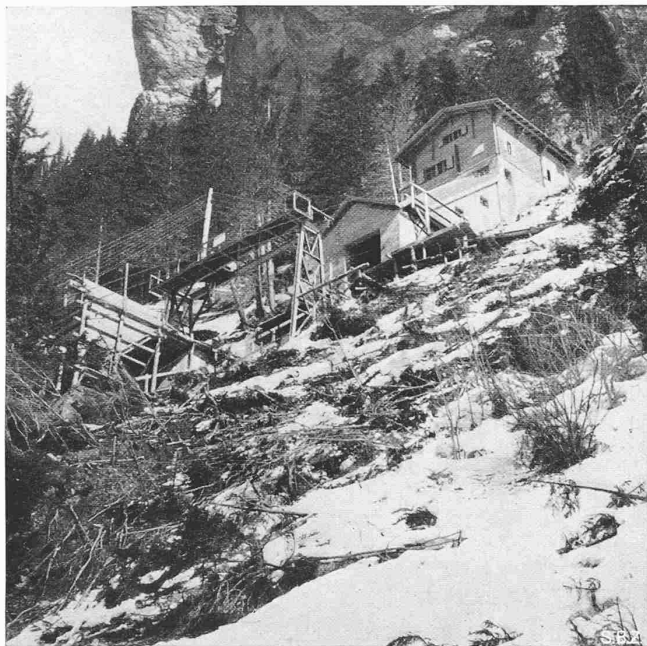
Abb. 5. Obere Endstation (Wasserschloss im Kapf) der Standseilbahn
