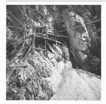
Abb. 7. Baufenster Mittagfluh des Zulaufstollens
