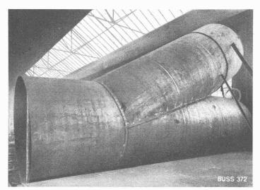
Abzweigrohr zum Wasserschloss
