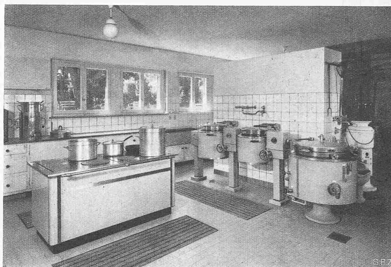
Abb. 6. Küche mit elektrischem Herd und Dampf-Kochapparaten
