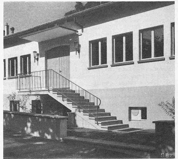
Abb. 3. Aussenzugang zum Saal
