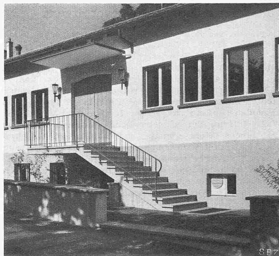
Abb. 3. Aussenzugang zum Saal
