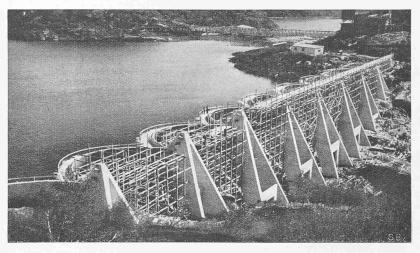
Abb. 8. Navanndamm des Vest Agder Elektrizitätswerks, im Bau
