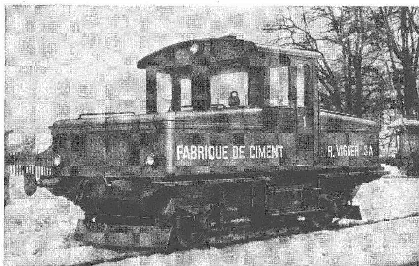
Elektrolokomotive mit Akkumulatoren-Batterie für Rangierdienst
