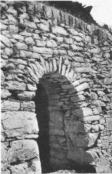
Abb. 6. Lawingalerie (1867) lagerhaft gut gemauert
