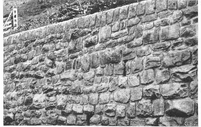
Abb. 2. Unschöne Futtermauer, weder Schichten- noch Zyklopmauerwerk. Mörtelfugen zu breit
