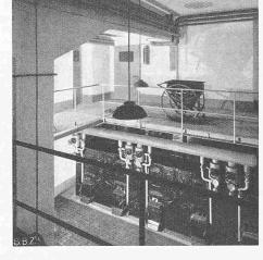
Abb. 15. Warmwasserkessel im Zentralheizraum
