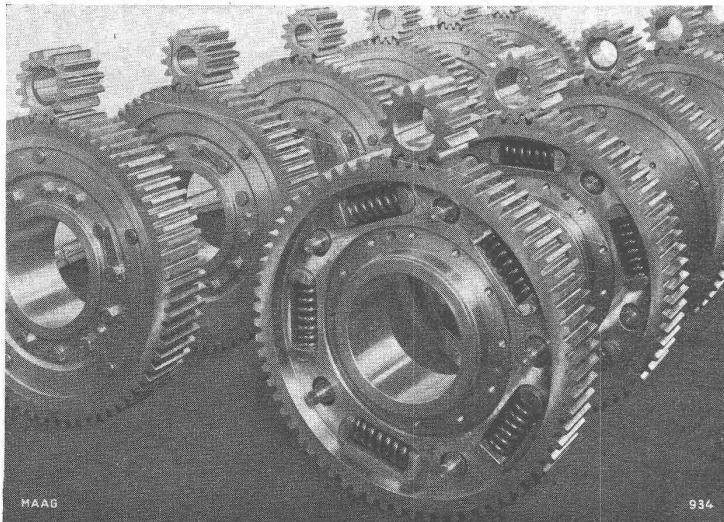
Maag - Protex - Getriebe neuester Konstruktion für die elektrischen Lokomotiven
