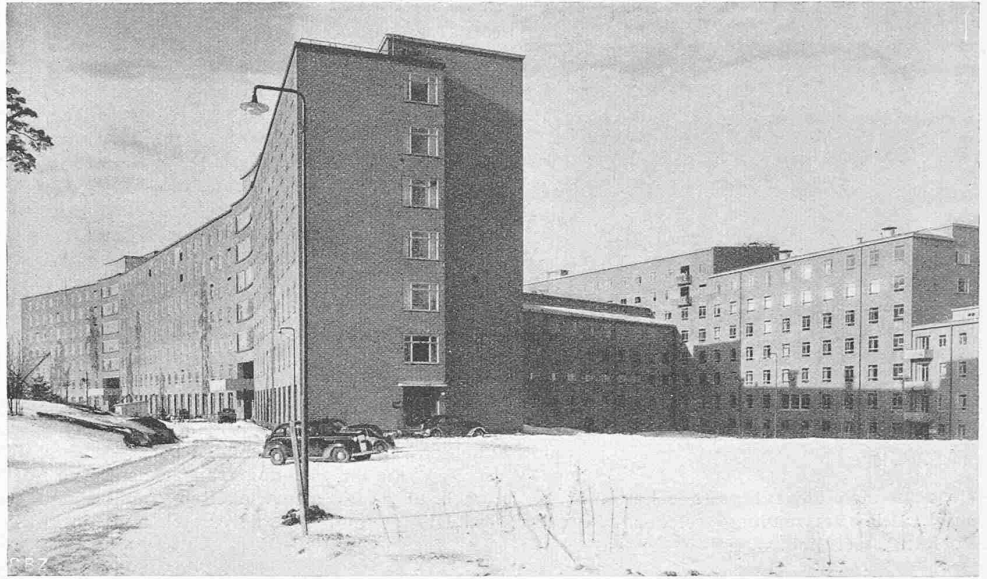
Abb. 3. Karolinska Universitäts-Krankenhaus Stockholm, Hauptkomplex aus Südosten
