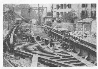
Abb. 5. Eisenkonstruktion des Fahrbahntroges (11. XI. 38)
