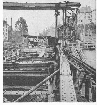
Abb. 7. Aeusserer gekrümmter Hauptträger in Montage (27. Oktl. 938)
