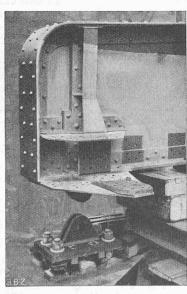
Abb. 8. Trägerende mit Pendellager und Endträgeranschluss
