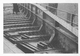
Abb. 6. Armierung des Fahrbahntroges. - Masstab 1:60
