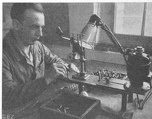
Bohren feiner Einspritzdüsenlöcher
