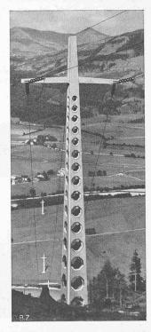
Abb. 4. Kastenform in Eisenbeton
