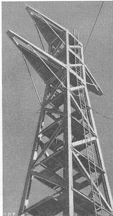
Abb. 2. Schleuderröhren-Gittermast Abb. 3. Gittermast in eiserner Schalung
