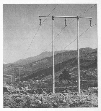
Abb. 1. Portal-Masten aus Schleuderröhren für 150 kV-Leitung
