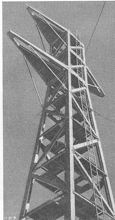
Abb. 3. Gittermast in eiserner Schalung
