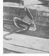
Abb. 13. Auflager der Fahrbahnplatte am Widerlager, 1:30
